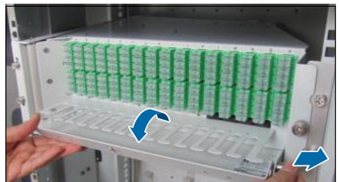
4 Ré intervention ou démontage des cordons par ouverture du volet avant.
