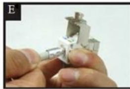
Positionner le capot sur les contacts IDC
